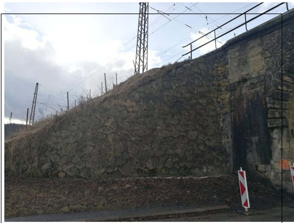
Obr. č. 13 - pohled na šikmé křídlo - v líci tvořené kyklopským zdivem, bez poruch
