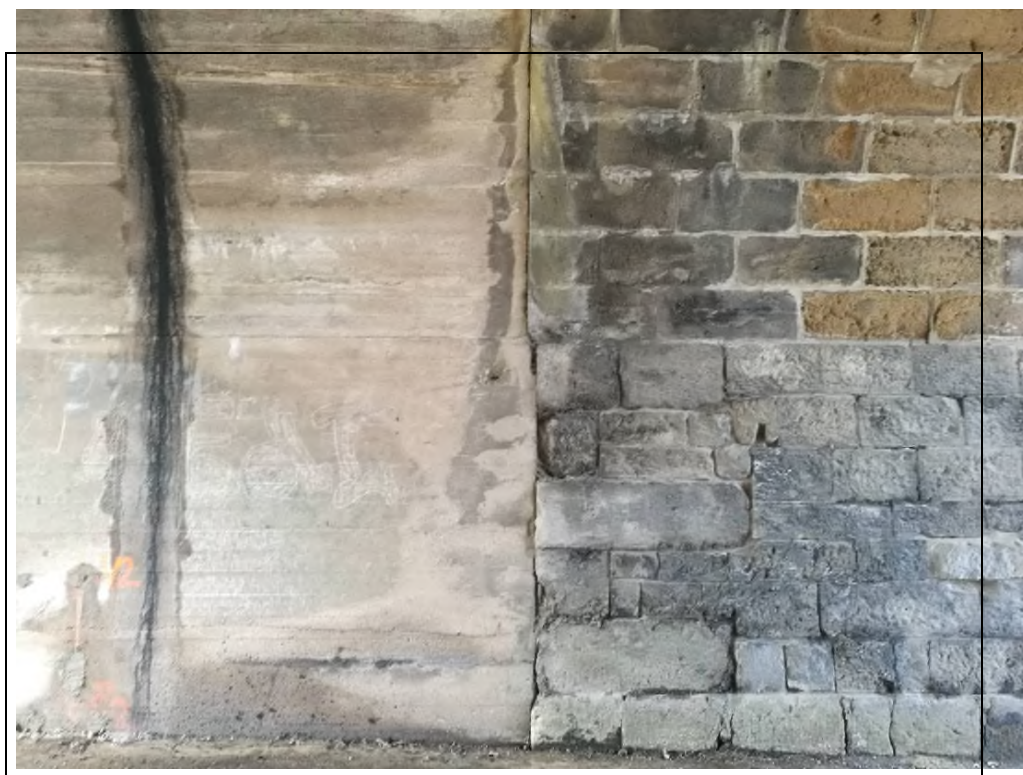
Obr. č. 19 - pohled na dilatační spáru mezi kamennou a betonovou částí konstrukce
