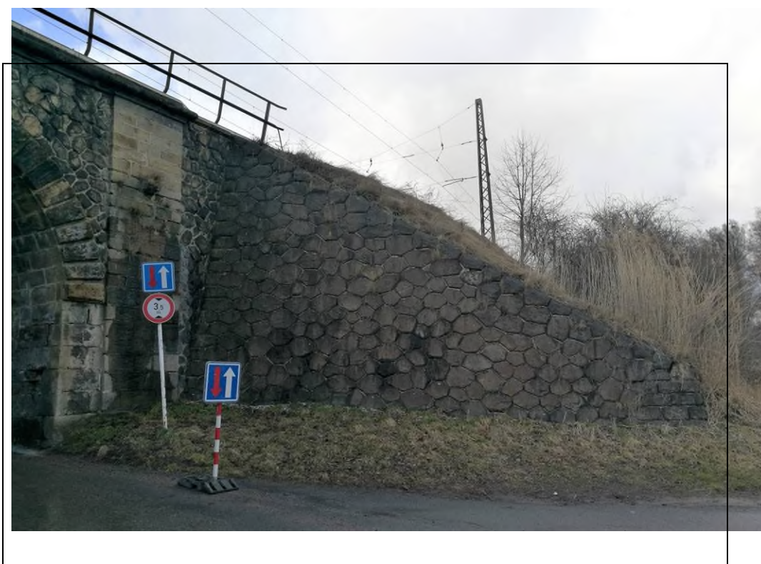
Obr. č. 14 - pohled na šikmé křídlo - v líci tvořené kyklopským zdivem, bez poruch
