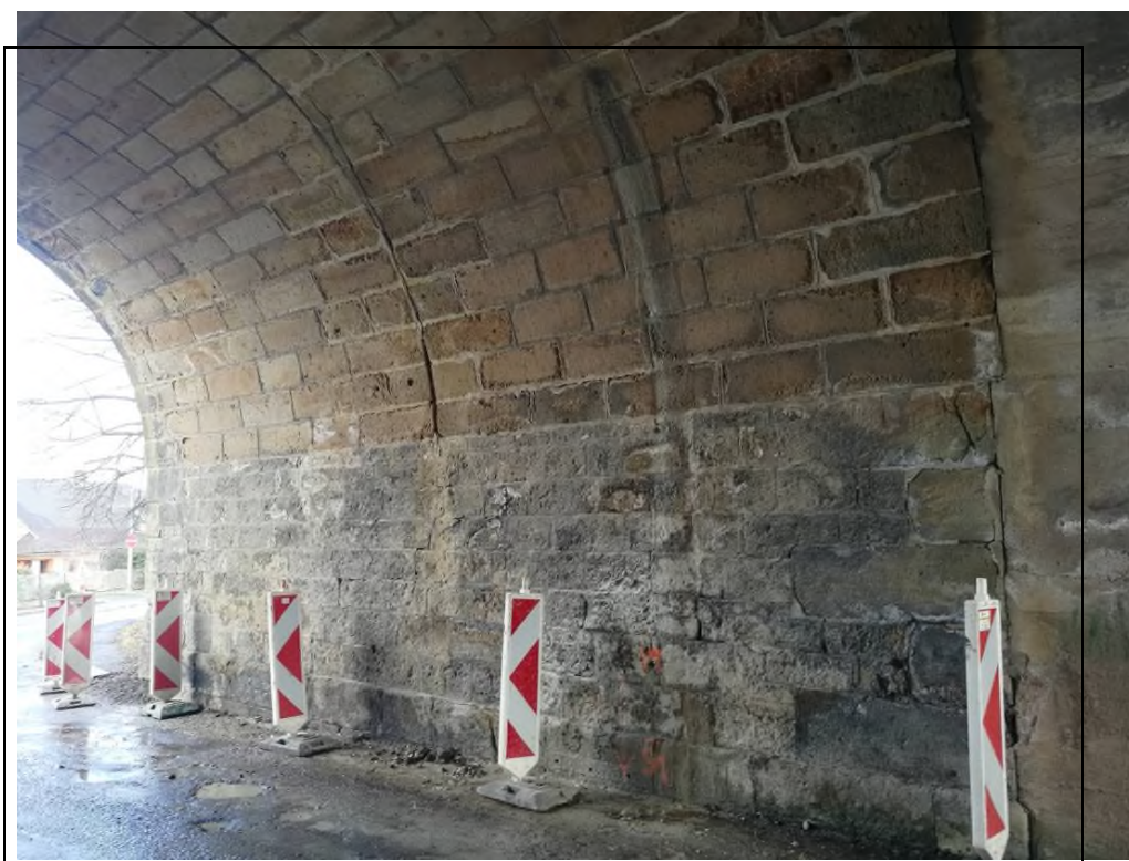
Obr. č. 11 - pohled na opěru Č. Třebová - v líci řádkové kamenné zdivo, degradované
