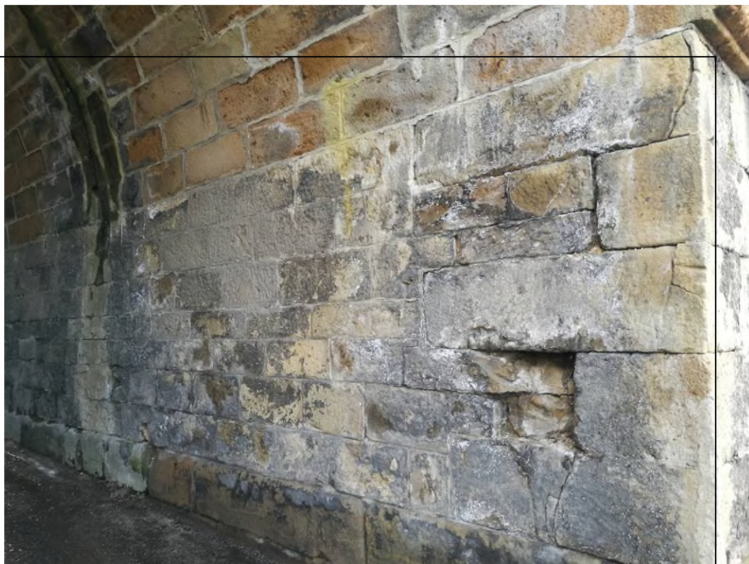
Obr. č. 10 - pohled na opěru Ústí n. O. - v líci řádkové kamenné zdivo, degradované
